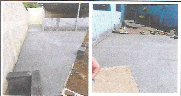
Foto 3: colocación de loza de patio
