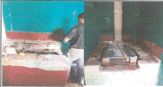
Foto1: Realizando los trabajos de sustitucion de plancha de cocina.
